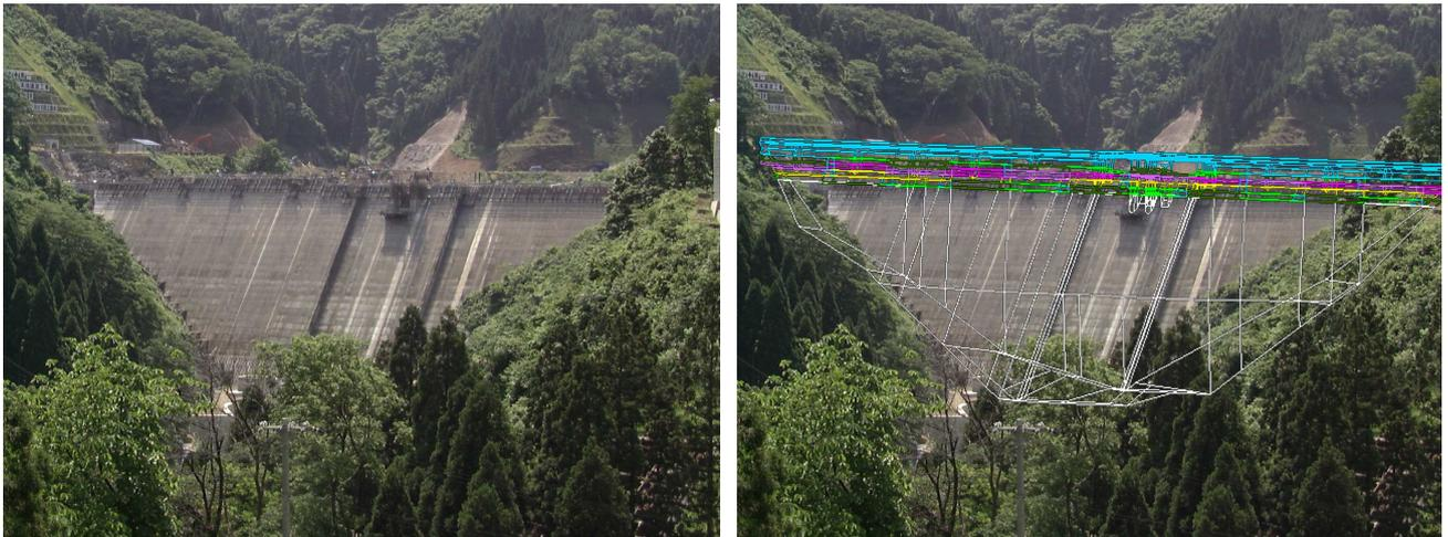
写真-3 重力式ダム現場におけるARシステムの適用例
