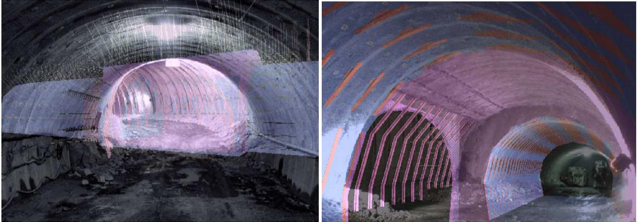
図-13 AR 技術によって可視化されたトンネル交差部の支保構造と支保部材
