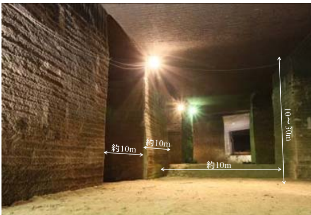
写真-1 地下空間内部の状況
