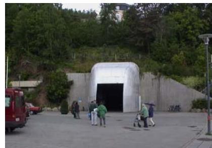
写真-3 オリンピック・マウンテン・ホールの入口
