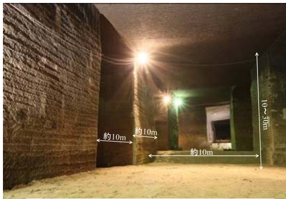
写真-1 地下空間内部の状況
